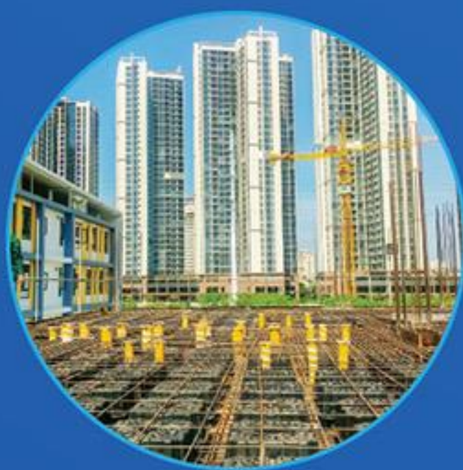
Dự án Projects
